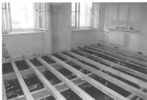
Wzmacnianie stropów nad poziomem I piętra
