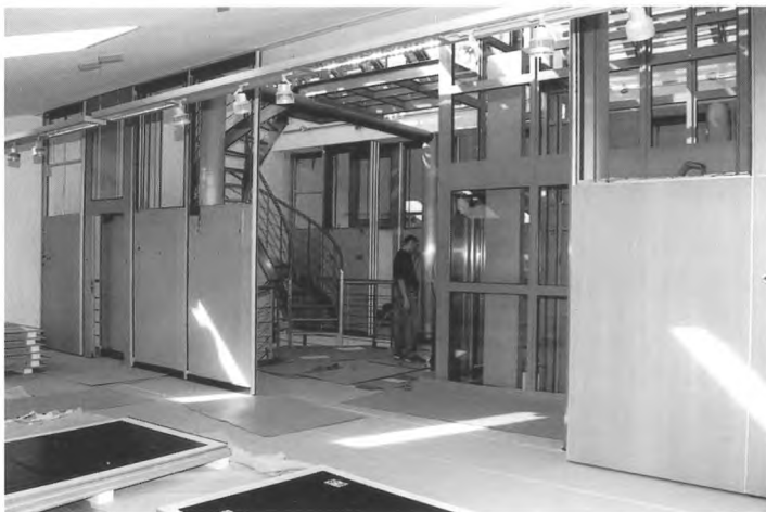
Montaż przesuwanych ścian działowych na IV piętrze kamienicy „Pod Kruki”
