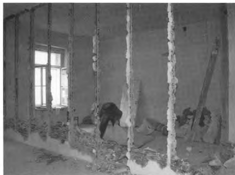
Wyburzanie jednej ze ścian działowych
