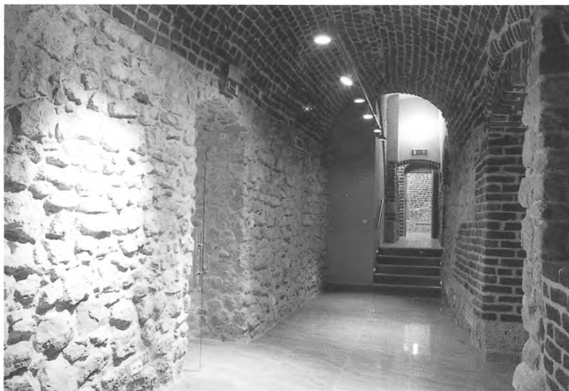
Środkowa sala po zakończeniu prac remontowo-konserwatorskich (maj 2003)
