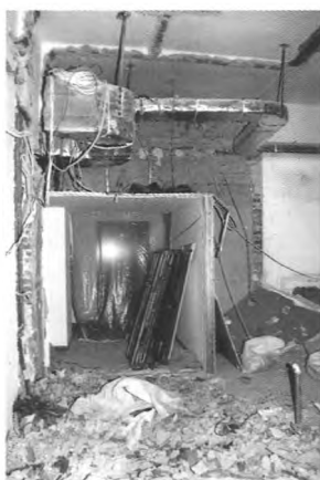
Tak kiedyś wchodziło się do Galerii... Przebudowa klatki schodowej umożliwiająca montaż windy przystosowanej dla osób niepełnosprawnych wg projektu Atelier Loegler i Partnerzy Sp. z o.o. (luty 2001)
