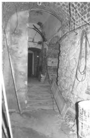
Prace przy wyrównaniu poziomu posadzek w środkowej sali (luty 2003)
