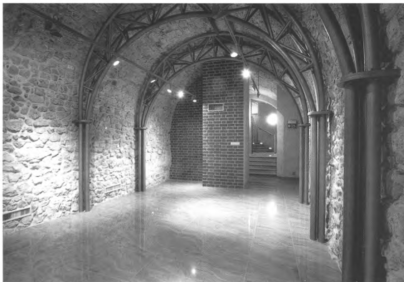
Główna sala z konstrukcją kratową podpierającą strop (maj 2003)
