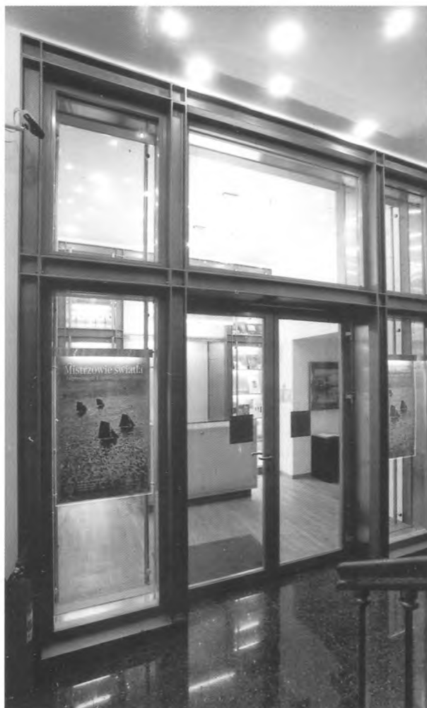
Nowy stalowo-szkłany portal wejściowy Galerii (luty 2003)
