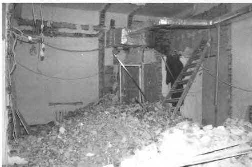
Adaptacja dawnego zaplecza Galerii Roboty budowlane przy prowadzeniu ciągów kanałów wentylacyjnych (lipiec 2003)
