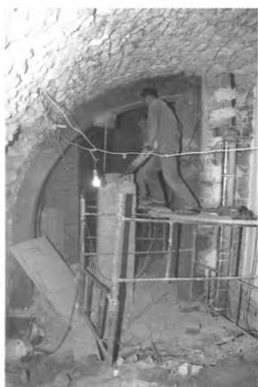
Prace wyburzeniowe związane z usunięciem betonowego filara w głównym pomieszczeniu piwnic (luty 2003)
