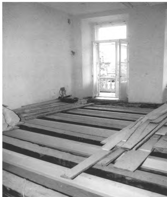
Galeria MCK podczas kolejnego etapu remontu
