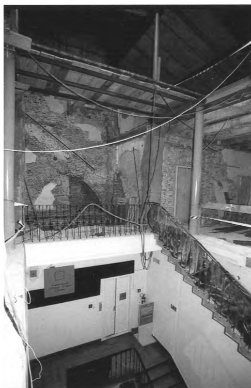
Klatka schodowa (styczeń 2001)
