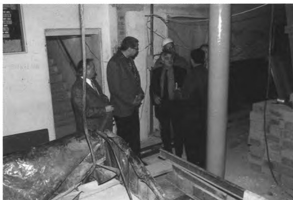
Kolejna wizja lokalna: dyr. Jacek Purchla wraz z dyr. Ryszardem Blachutem i autorem projektu przebudowy dr. Romualdem Loeglerem na placu budowy (grudzień 2000)
