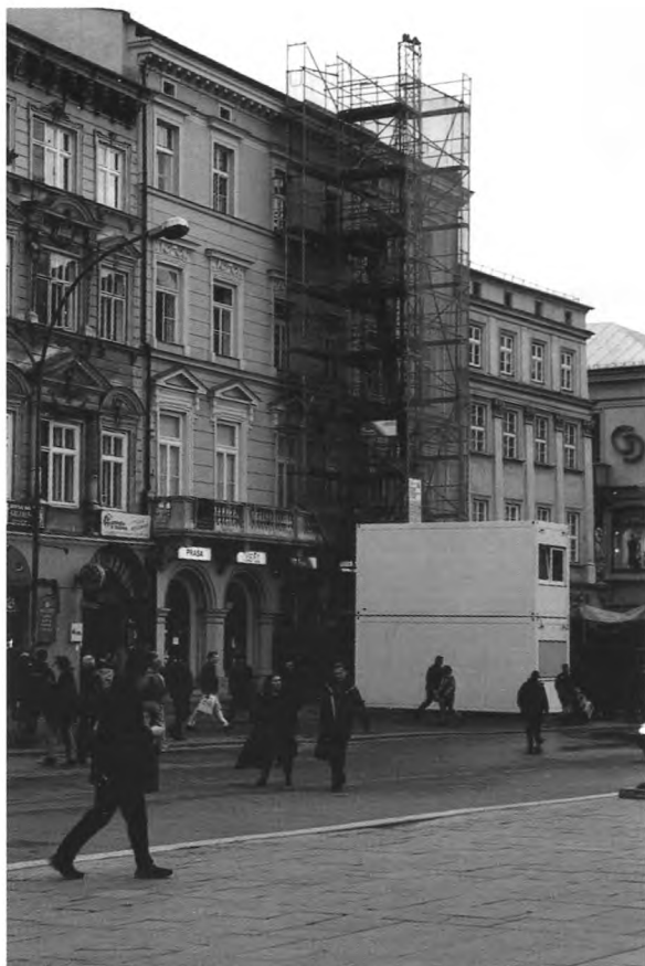
Fasada frontowa podczas remontu (grudzień 2000)
