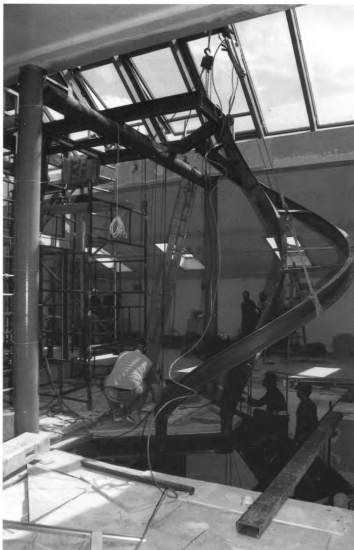
Montaż schodów prowadzących na IV piętro i platformę widokową (maj 2001)
