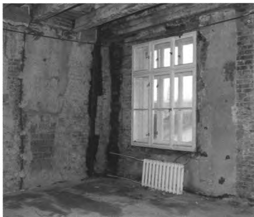
Pomieszczenia III piętra od strony oficyny (styczeń 2001)
