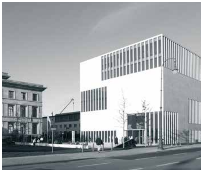
Nowo wybudowane Centrum Dokumentacji NS w Monachium (NS-Dokumentationszentrum München)
