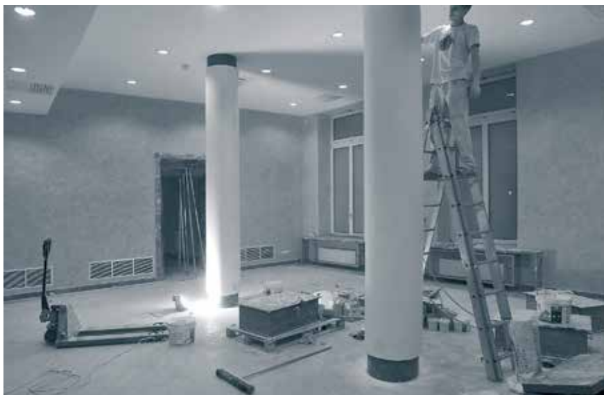
Ofcyna – prace wykończeniowe w foyer sali „Pod Kruki” (grudzień)
