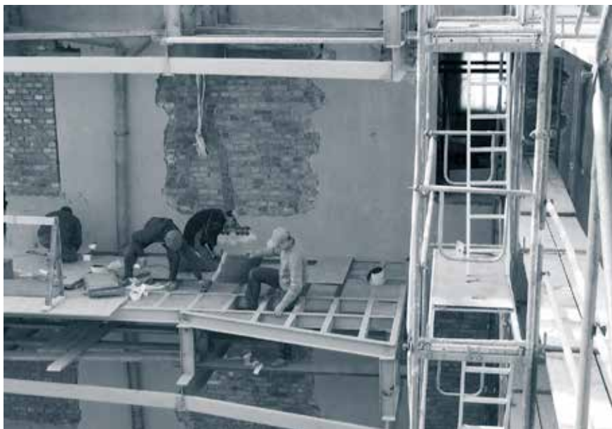
Patio – powstająca konstrukcja wykusza przyszłej Czytelnii Rolanda Bergera (marzec)
