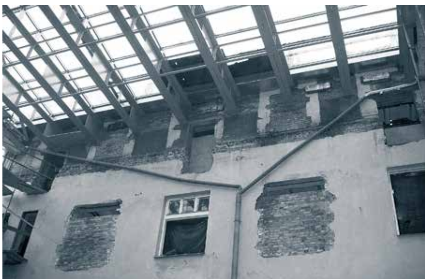
Patio – ruszają roboty wewnątrz (styczeń)
