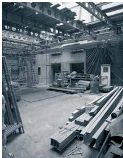
Sala „Pod Kruki” – nowe stalowe belki stropowe (luty)
