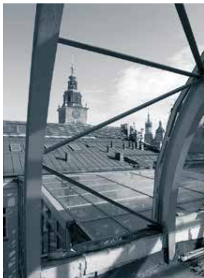
Oficyna – kratownica ścian sali panoramicznej (luty)
