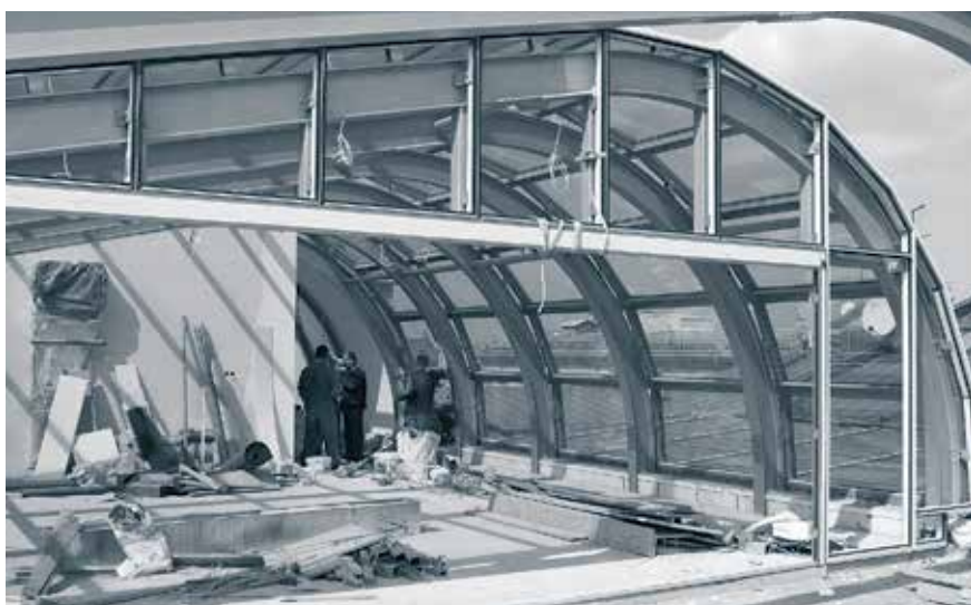
Oficyna – prace wykończeniowe w sali panoramicznej (wrzesień)
