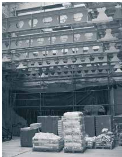
Sala „Pod Kruki” – stalowe belki nowego stropu (kwiecień)
