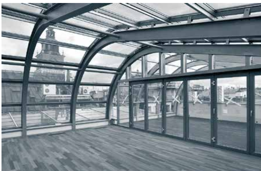
Oficyna – prace wykończeniowe w sali panoramicznej (listopad)
