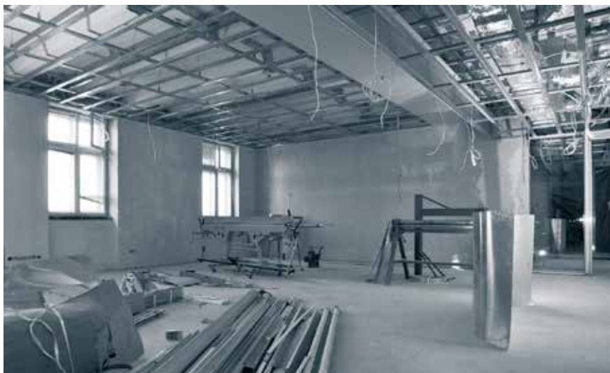
Oficyna – prace wykończeniowe w nowej Bibliotece MCK (sierpień)
