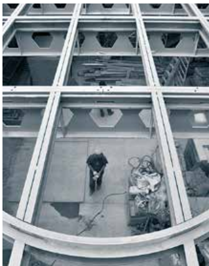
Patio – powstająca konstrukcja świetlika sali „Pod Kruki” (kwiecień)
