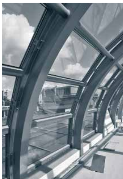
Oficyna – przeszklenie w sali panoramicznej (wrzesień)
