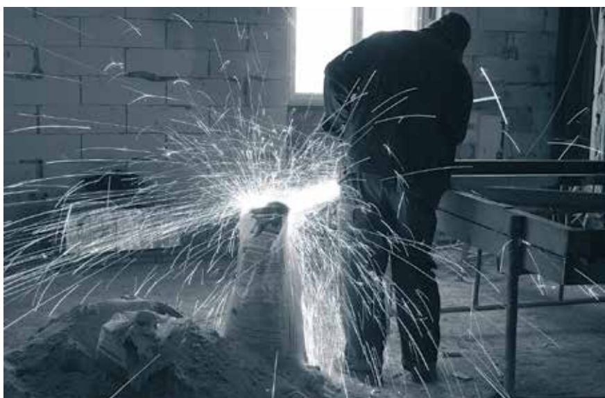
Oficyna – wiele elementów stalowych powstawało na miejscu (marzec)
