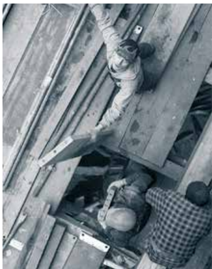
Patio – prace bez użycia ciężkiego sprzętu budowlanego wymagały niezwykle sprawnej organizacji (styczeń)
