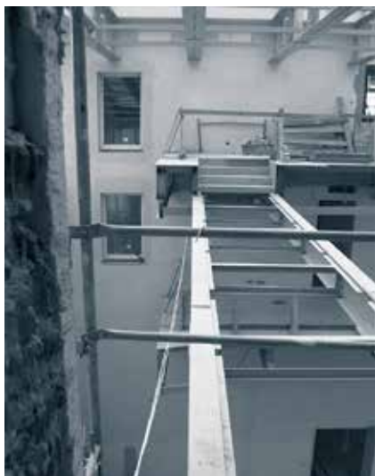
Patio – konstrukcja kładki pomiędzy kamienicą i oficyną (maj)
