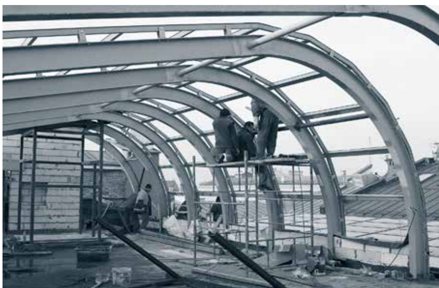
Oficina – montaż ramy dla szklanych paneli ścian i dachu sali panoramicznej (styczeń)
