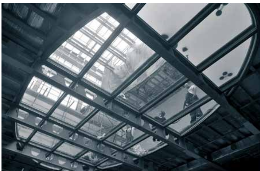
Sala „Pod Kruki” – zasklenie świetlika (czerwiec)
