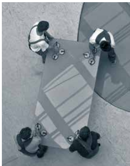
Sala „Pod Kruki” – zasklenie świetlika (czerwiec)
