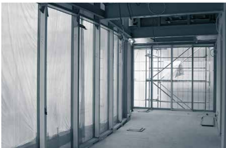
Patio – wnętrze wykusza przyszłej Czytelni Rolanda Bergera (lipiec)
