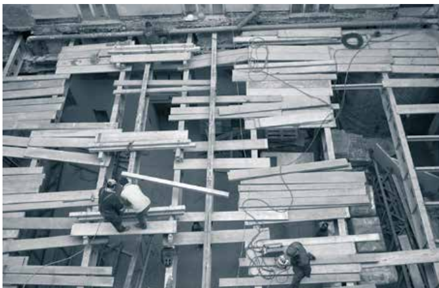
Patio – wkrótce powstanie nowy strop sali „Pod Kruki” a zarazem podłoga patio (luty)
