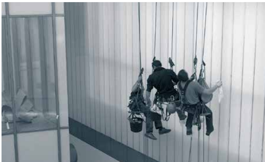
Patio – prace wykończeniowe ścian kurtynowych (październik)
