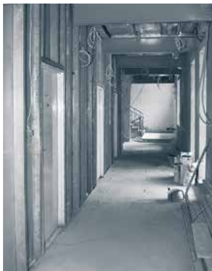
Oficyna – ściany działowe nowych pomieszczeń Instytutu Dziedzictwa Europejskiego (kwiecień)
