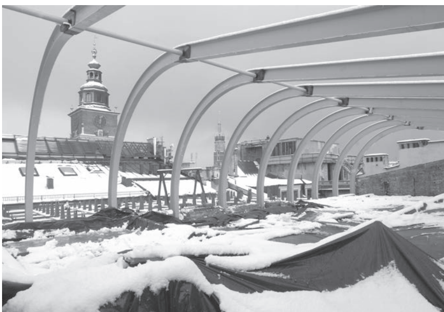
Listopad – montaż dźwigarów szklanego przekrycia dziedzińca mck oraz żeber wspierających transparentny dach oficyny
