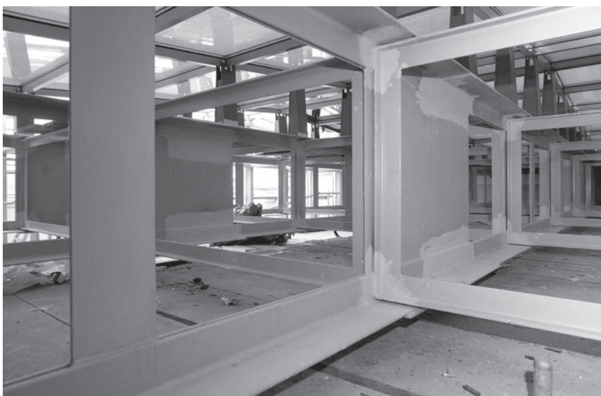
Grudzień – rozpoczęto wypełnianie szklanymi panelami konstrukcji przekrycia i ścian kurtynowych dziedzińca mck
